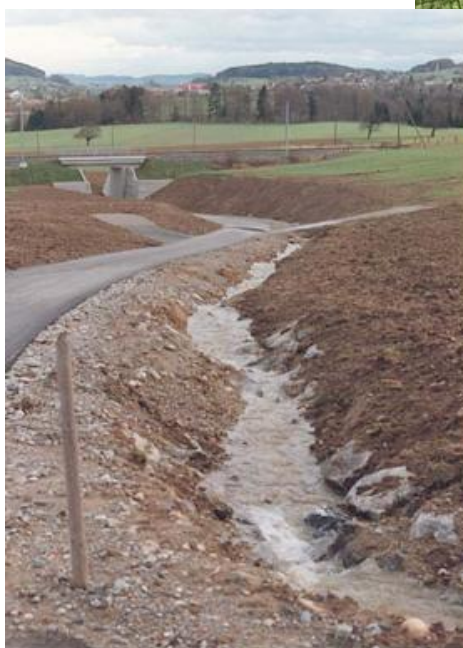
Neue Bahnunterführung, revitalisiertes Wiesenbächlein
