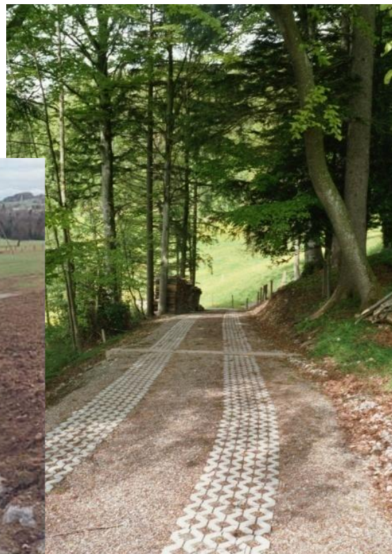
Bewirtschaftungsweg mit Rasengittersteine
