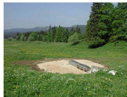
aménagement d'un captage
