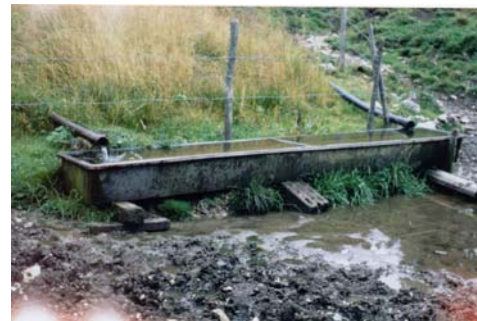
captage à restaurer
