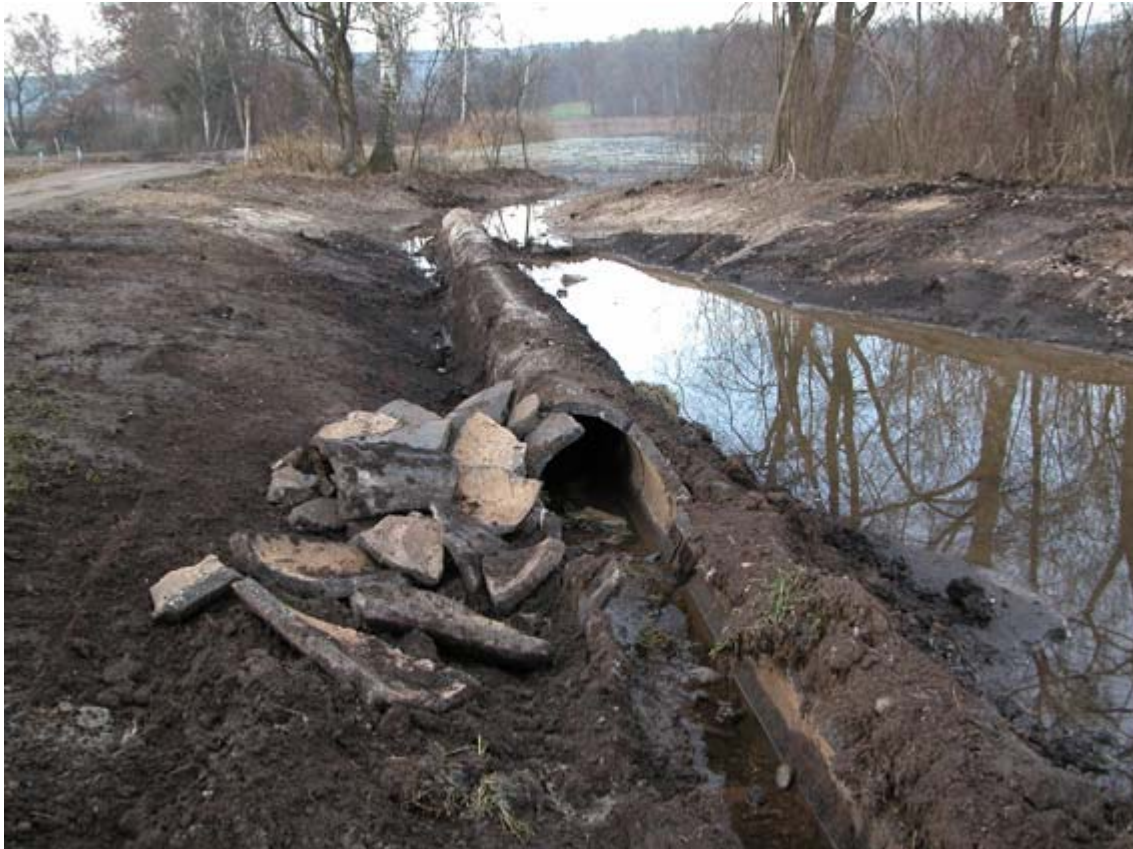
Démolition de tuyaux de drainage
