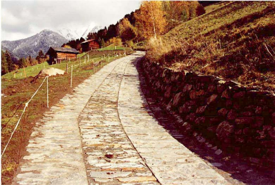
Le tronçon « Riedgasse » du chemin d'Albrun après la réfection
