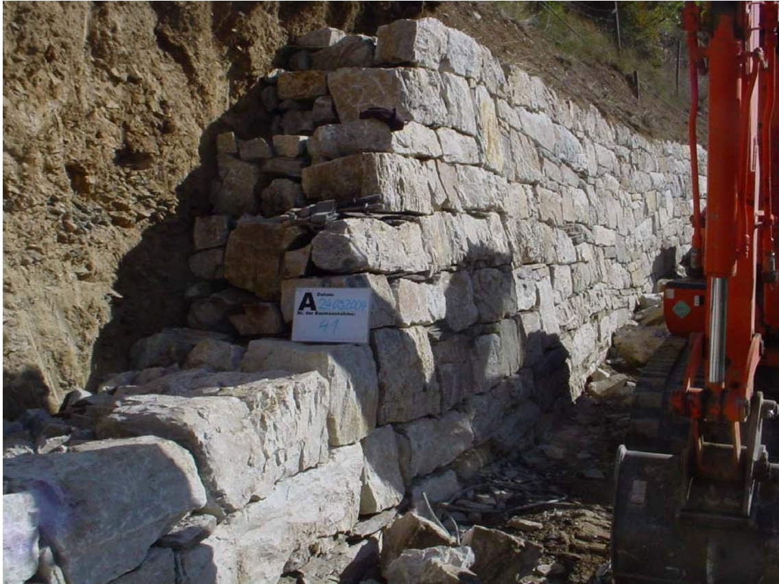
Construction durable de murs de pierres sèches
