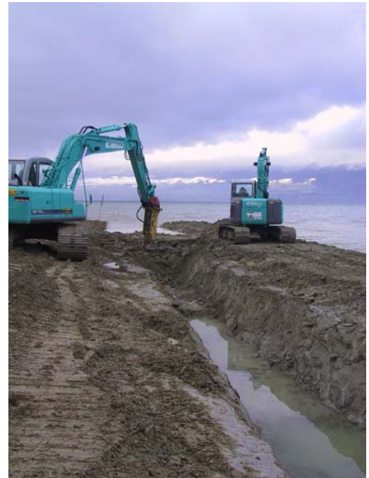
Travaux de fouille pour la pose de la conduite d'alimentation reliant la prise d'eau à la station de relevage.
