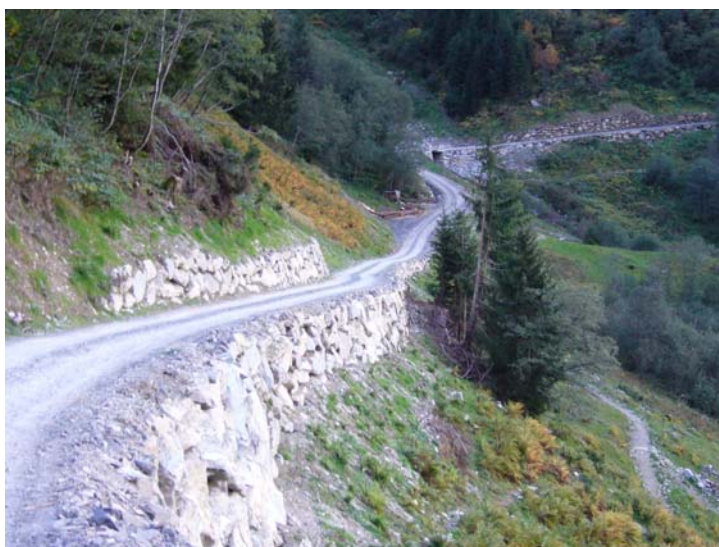
Nouveau tracé avec solides protections de talus
