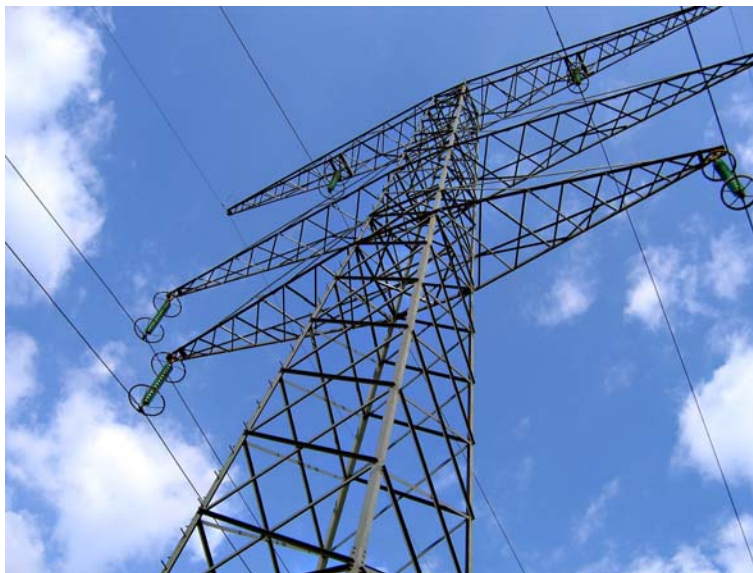
Les lignes électriques peuvent parfois être une source de courants vagabonds
