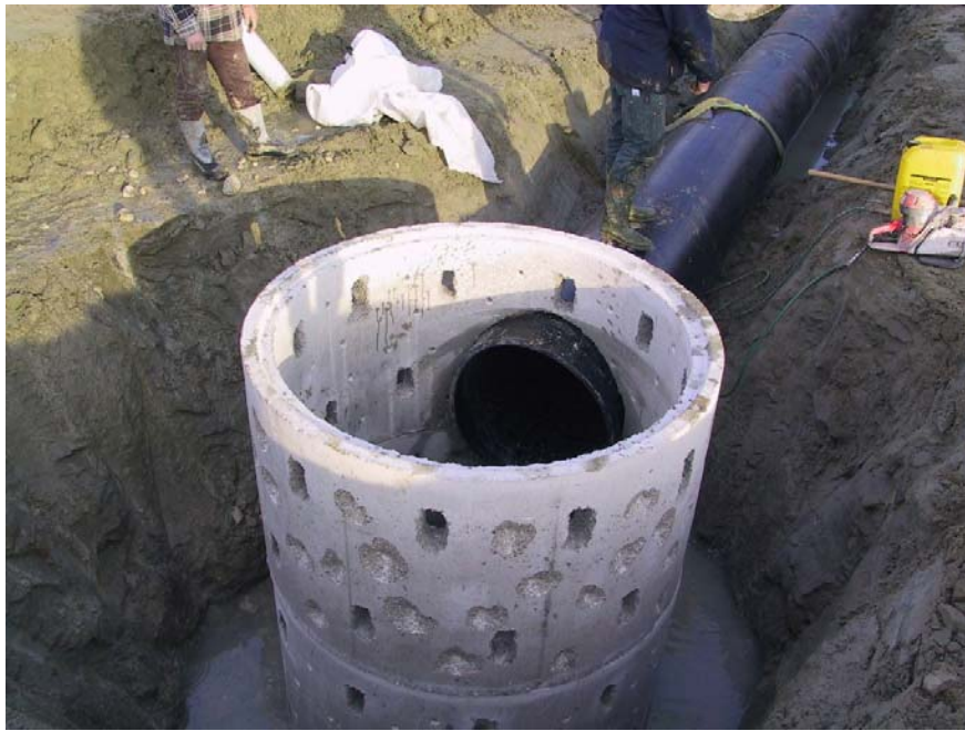
Pose à la trancheuse des tuyaux de refoulement
