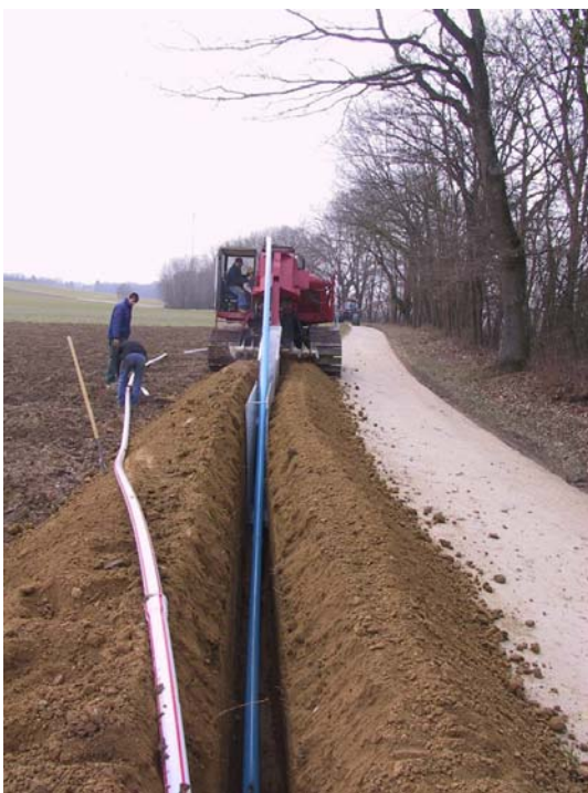
Pose à la trancheuse des tuyaux de refoulement
