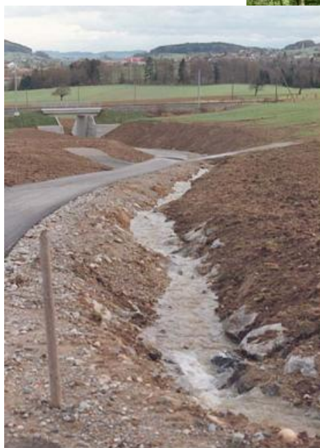
Nouveau passage sous-voie, ruisseau de prairie revitalisé
