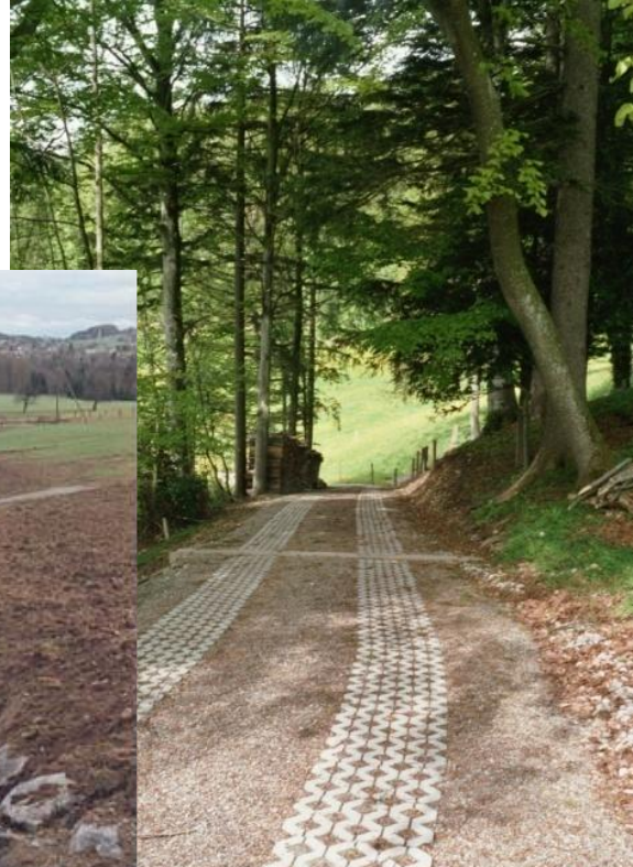
Chemin d'exploitation avec grilles-gazon
