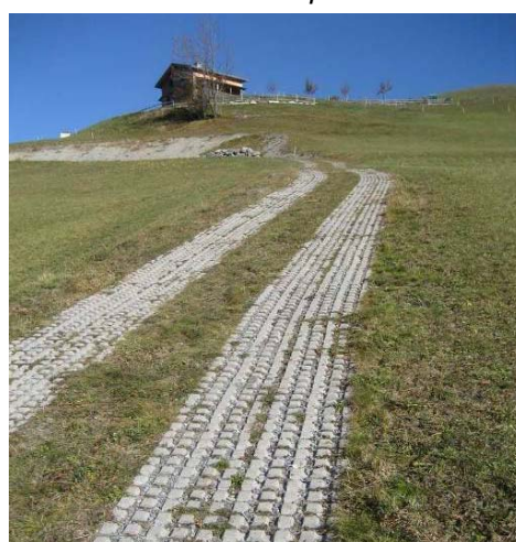
Le guidovie in grigliato di calcestruzzo si prestano anche alle strade agricole a pendenza molto forte, come a Valendas (GR)
