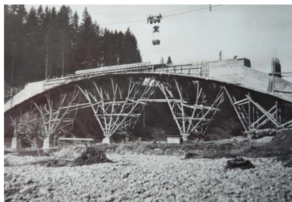
Lavori di costruzione del ponte sul Rossgaben con centine e teleferica (foto del 10 ottobre 1932)
