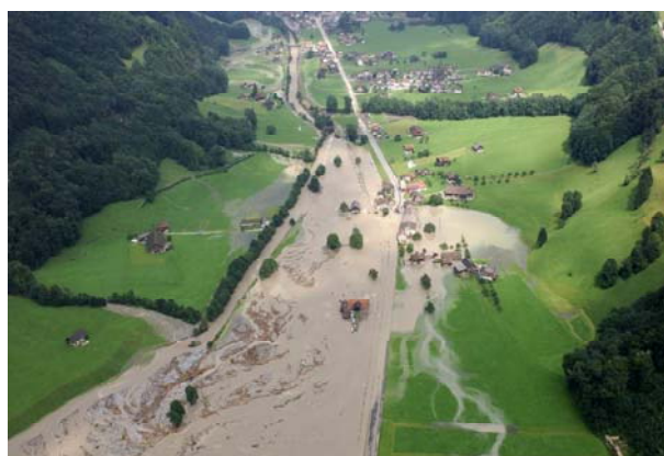
Delimitazione delle competenze tra il settore delle opere idrauliche e quello agricolo, Lütschental (BE)
