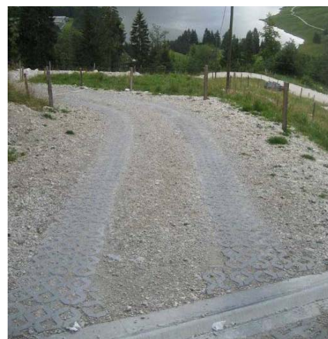
Via d'accesso all'alpe della Breccaschlund (Lago Nero FR) con guidovie con grigliato erboso in calcestruzzo ed elementi prefabbricati (in primo piano) per l'evacuazione delle acque superficiali
