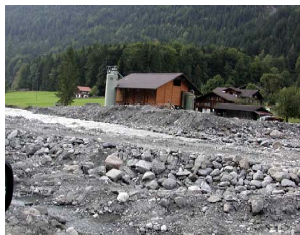
Interfaccia opere idrauliche – agricoltura, Wolfenschiessen (NW)
