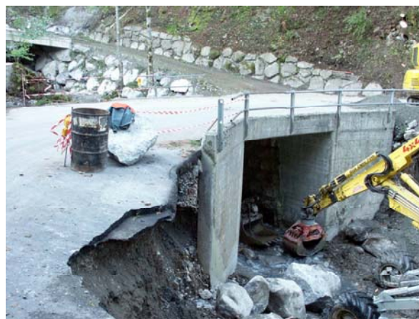
Ripristino di un ponte agricolo, Diemtigen (BE)
