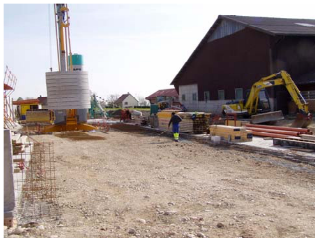
Fase di costruzione delle fondamenta e piastra di fondazione dell'aggiunta all'edificio di economia rurale esistente
