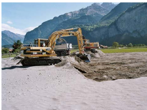
Sgombero di detriti grossolani da terreni alluvionati, Meiringen (BE)
