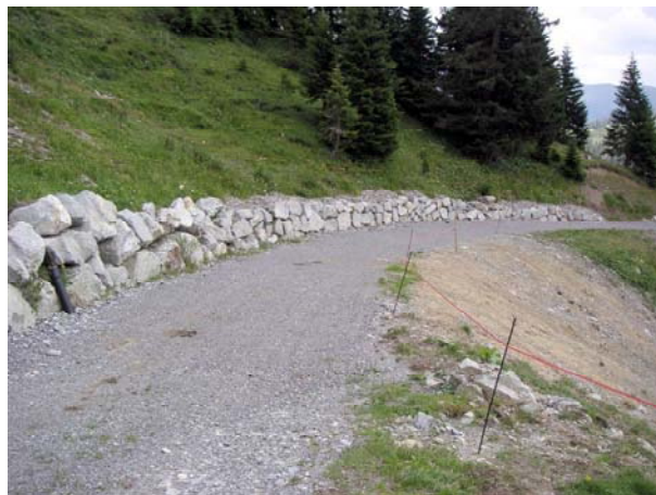
Ripristino di una strada agricola con scarpata ricoltivata, Lenk (BE)
