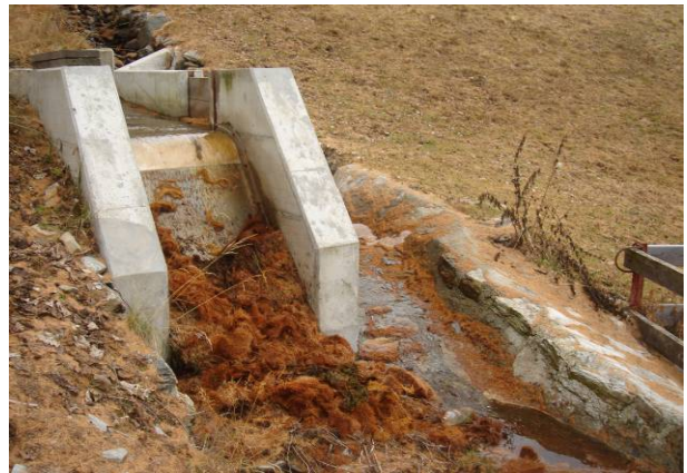
Moderna captazione dell'acqua in un tradizionale canale d'irrigazione (in ted. Suone e in fr. bisse) all'inizio di un impianto fisso di irrigazione a pioggia
