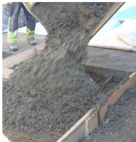
Come a Scheid (GR), le barre d'armatura proteggono il calcestruzzo dal peso eccessivo dei veicoli e riducono le quantità di calcestruzzo da trasportare
