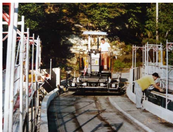
Posa del rivestimento del ponte sul Rossgaben (estate 2005)
