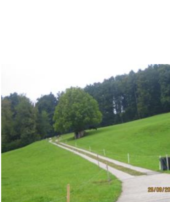
Guidovie in cemento con linea di mezzera erbosa
