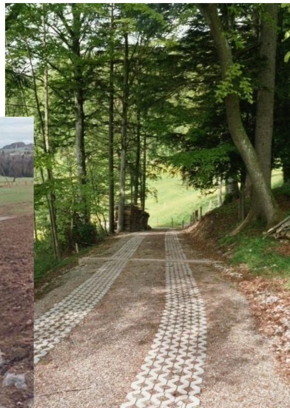
Accesso agricolo per la gestione di fondi con grigliato erboso carrabile
