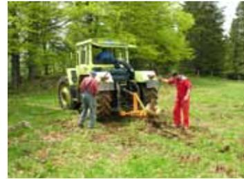
Pose de conduites à la soussoleuse
