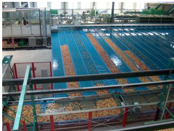
Anlage zur Produkttriage mittels Wasserkanälen
