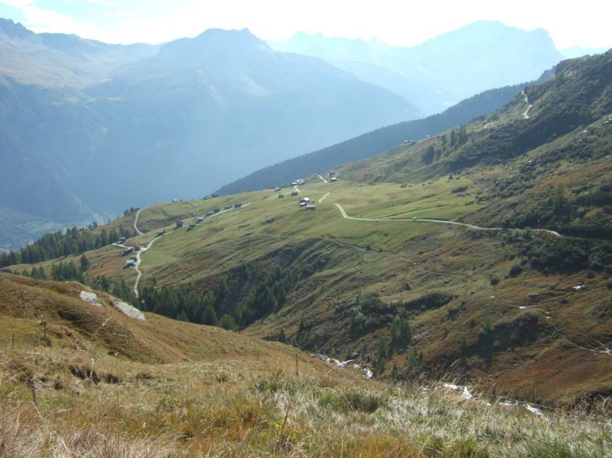
Erschliessungen mit Betonspurwegen am Schamser Berg, Kt. Graubünden
