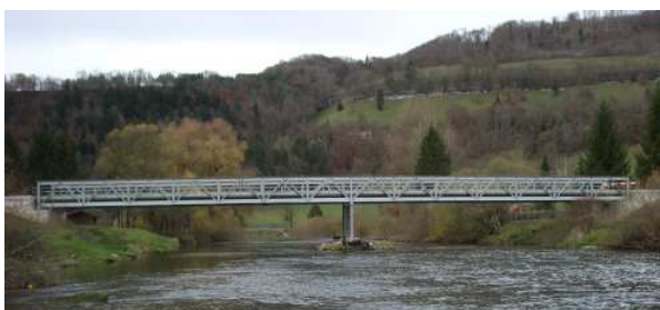
Brücke nach der Sanierung (Gesamtansicht)
