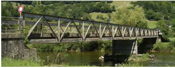
Brücke vor Baubeginn (Gesamtansicht)
