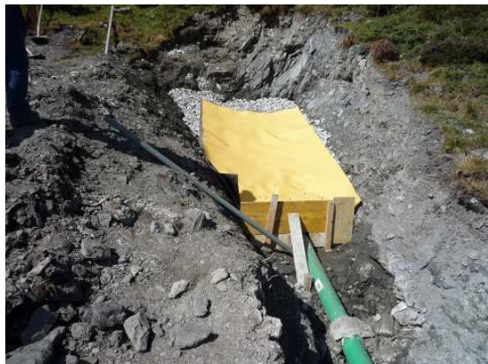
Die Sanierung von Quellfassungen am Rande von Flachmooren erfordert besonders sorgfältiges Bauen und die Anleitung durch eine ökologische Baubegleitung
