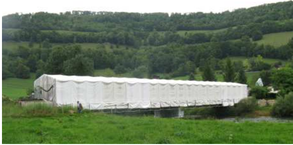
Hülle während der Bauarbeiten
