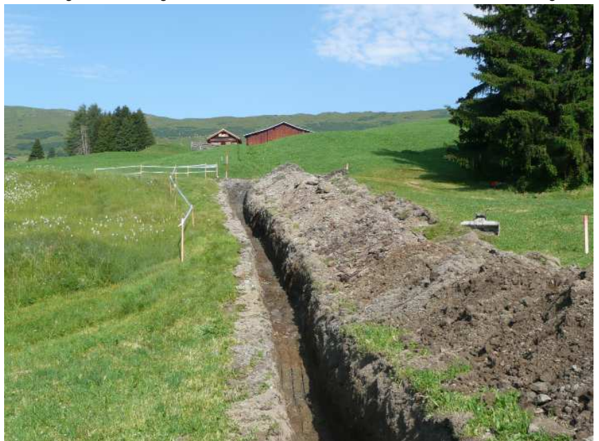
Schonungsvoller Leitungsneubau am Rande eines Flachmoores mit minimalen Eingriffen
