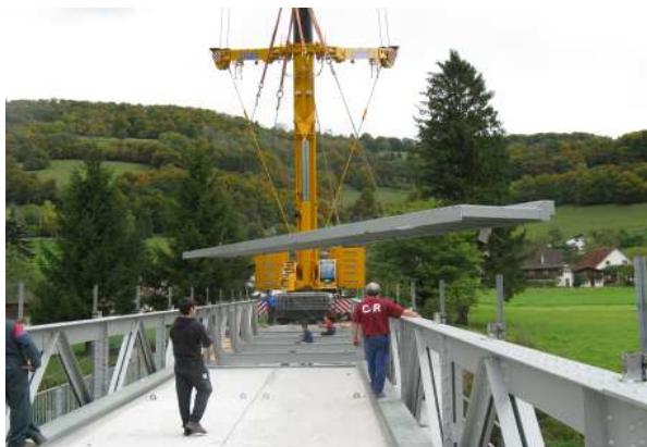
Montage der neuen Fahrbahnplatte (Kran mit Plattenelement)
