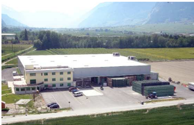
Luftbild der Vermarktungshalle in der Industriezone von Vétroz
