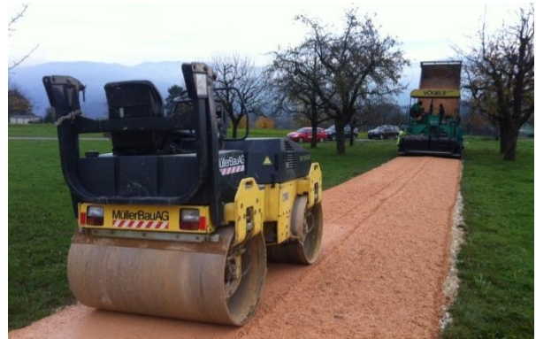
Neubau eines Mergelweges, Blauen
