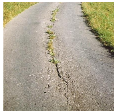
Mittelriss in einem Asphaltweg
