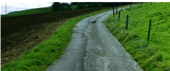
Aufgrund eines zu hohen Erd- und Graswalls am linken Wegrand kann das Niederschlagswasser die Strasse nicht regelmässig verlassen. Das anfallende Wasser konzentriert sich. Ein Abranden wäre sinnvoll.
