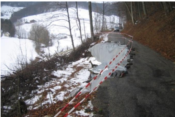
Abrutschung eines Strassenstücks, Eptingen
