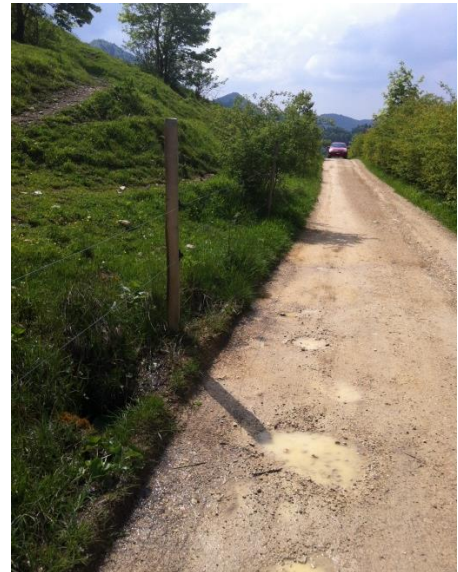
Schlaglöcher auf Mergelweg, Waldenburg
