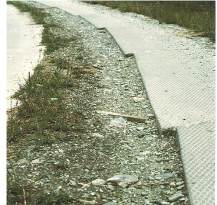
Auswaschung von Material zwischen den Fahrspuren. Das in der Mitte fliessende Wasser kann den Weg nicht verlassen.
