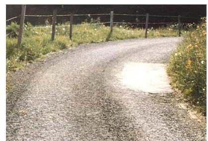
Altersbedingte Ausmagerung des Deckbelages.
