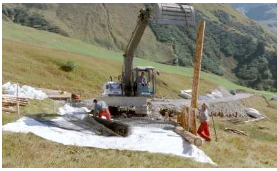
Traversée d'un bas-marais avec intégration de rondins et de ballast en granulés de verre cellulaire
