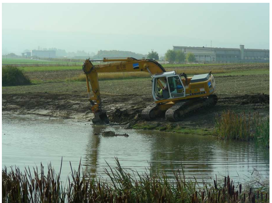
Pelleteuse au service de la nature / Pré Bovet - terrassement 2004
