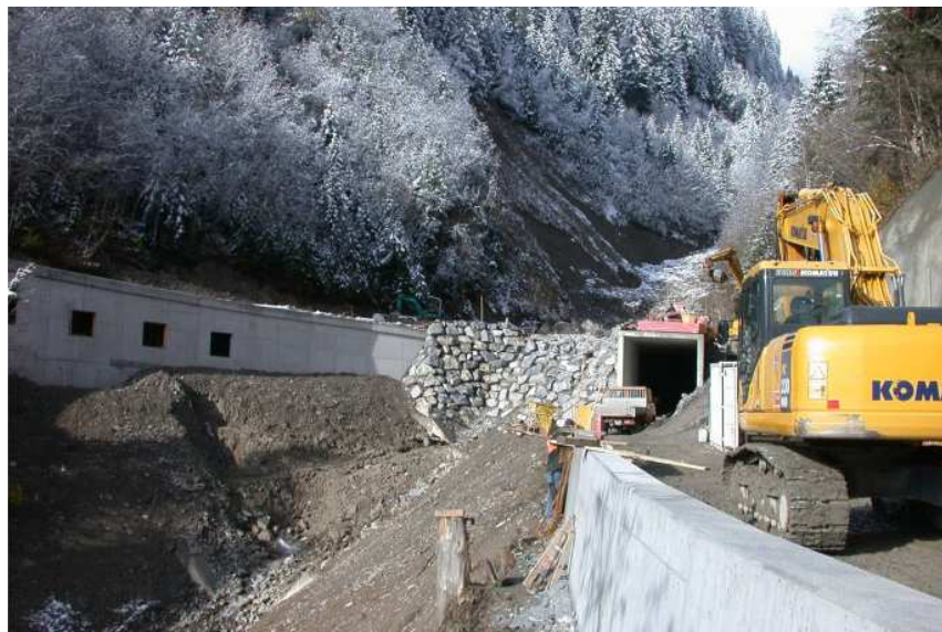
1. étape: gros-œuvre de la galerie du Zwüschebächgrabe en cours de construction, octobre 2009
