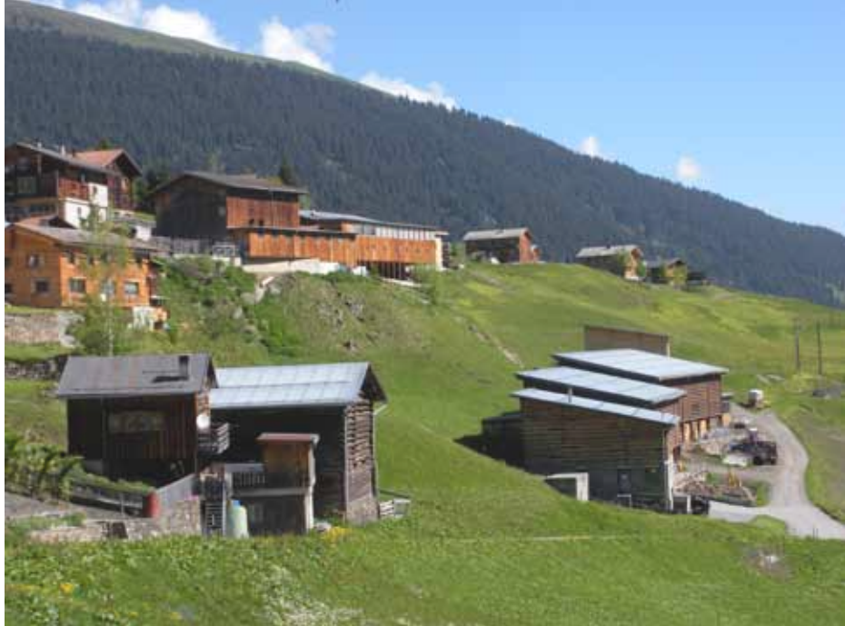
Abattoir et nouvelles étables à la lisière sud de Vrin
