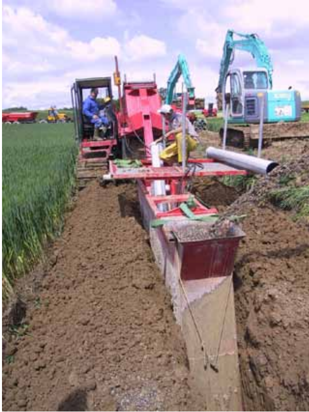
Les techniques actuelles permettent des réalisations « tout en 1 » compactes et rapides. Ici, pose d'un collecteur avec une « trancheuse à étaillage glissant ».
