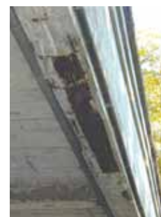
Armatura laterale del sottoponte scoperta
