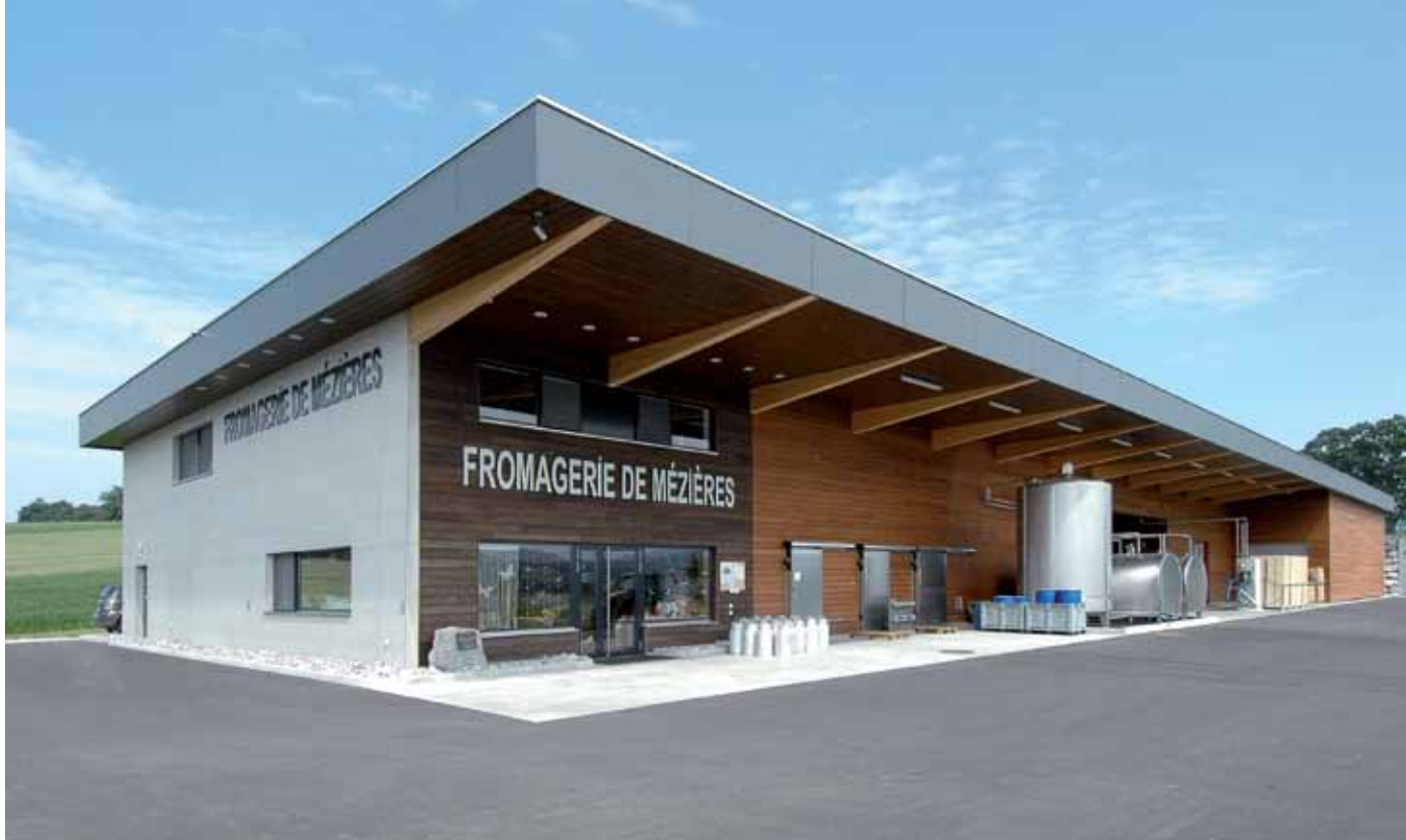
Nuovo caseificio della Société de fromagerie régionale de Mézières et environ con, in primo piano, il negozio, al centro, i locali per la presa in consegna e la trasformazione del latte e, sullo sfondo, la cantina. L'edificio è l'espressione di come si possano coniugare in maniera ottimale architettura moderna, elevata funzionalità e adeguate possibilità di ampliamento
