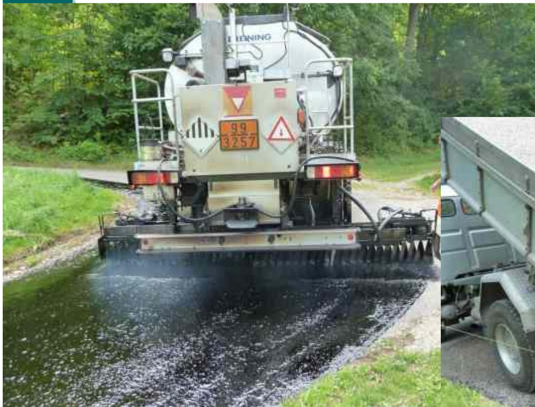
Bitumen und Splitt 8/11mm
