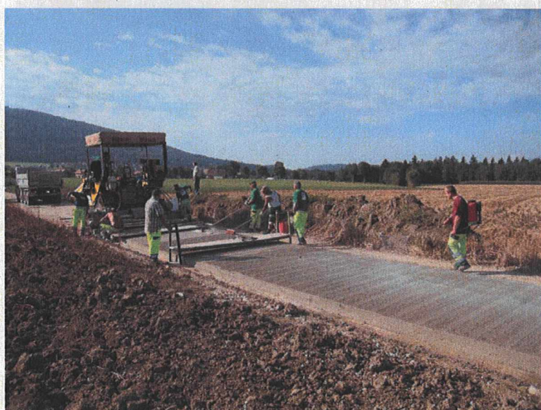
Bétonnage d'un chemin à Engollon, 2012
