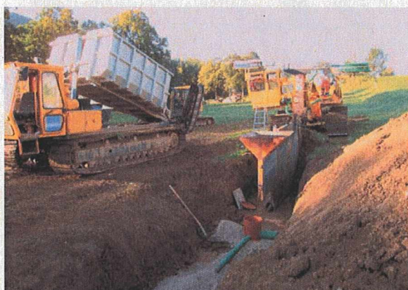
Travaux de drainages à Engollon, 2011
